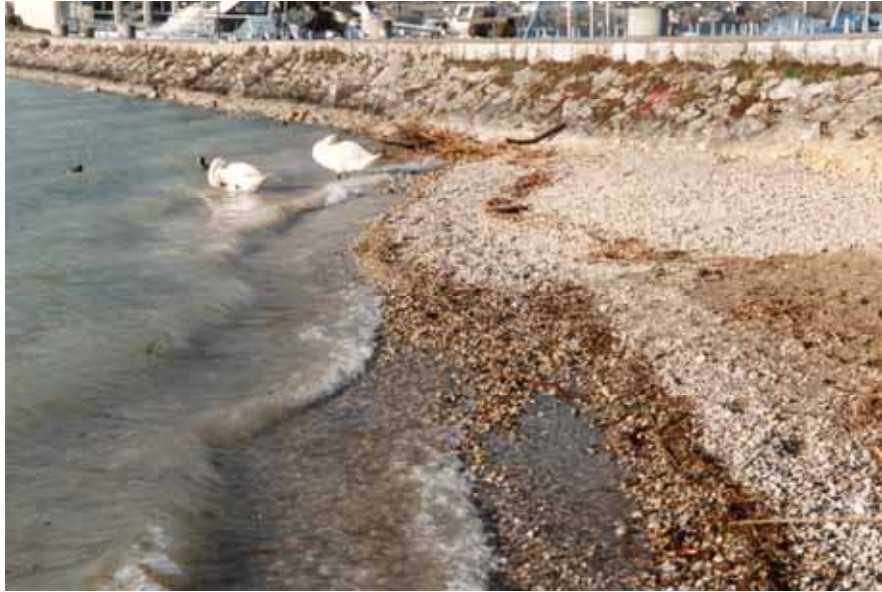
Abb. 6: Eine Mole bildet den seitlichen Abschluss der Kiesschüttung. Die Wellen werden der Mole entlang jedoch beschleunigt und treffen mit erhöhter Energie auf den Kieskörper auf. Bereits kurz nach dem Einbau ist hier eine Materialverlagerung entlang des Dammfusses festzustellen. Dies führte in der Folge zu einer übersteilen Böschungsneigung, weshalb die Stelle nachträglich mit einer Pflasterung aus Blöcken gesichert werden musste
