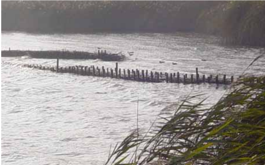
Abbildung 3: Wellendämpfende Wirkung von Lahnungen
