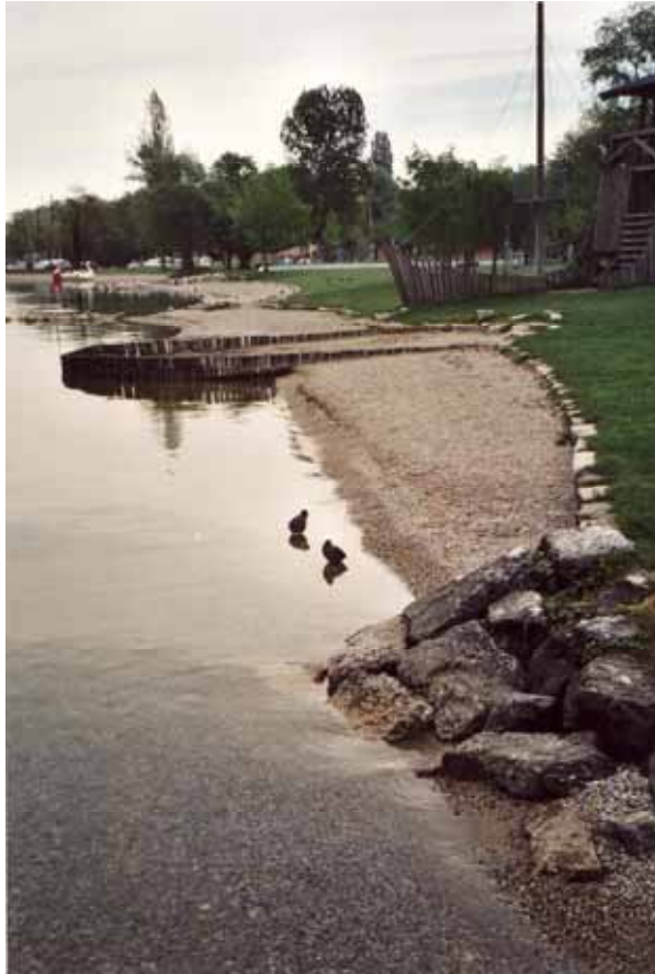
Abb. 5: Die Verjüngung der Böschungsbreite gegen den Vordergrund hin hat eine übersteile Böschungsneigung zur Folge. Die Kiesschüttung wird durch die Brandung jedoch abgeflacht, was zu einem Verlust von Material durch seitliche Verfrachtung in Richtung des Betrachters oder zu einer Unterspülung der Blockreihe an der Böschungsoberkante führt.
